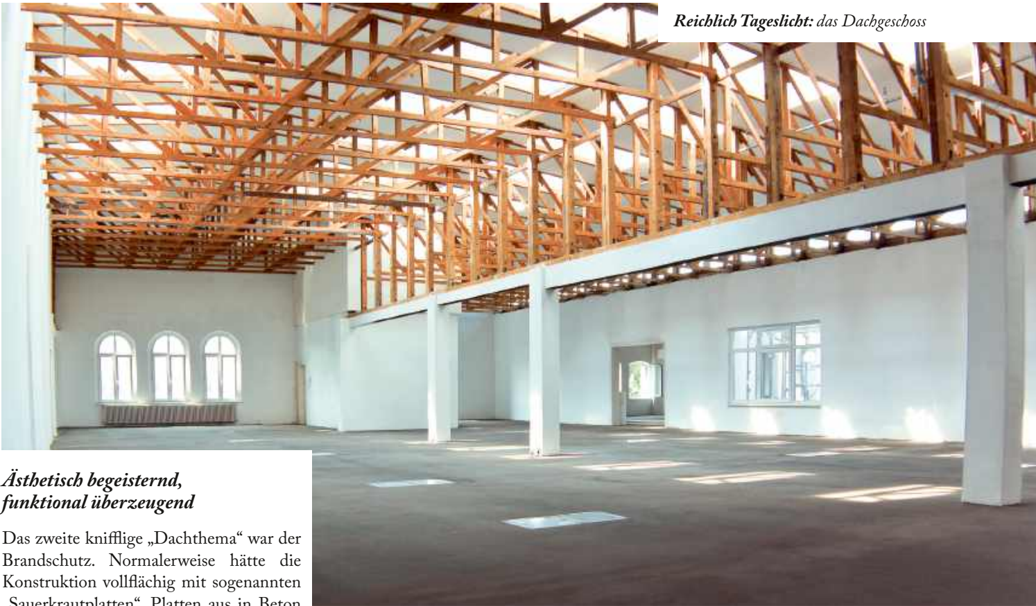
Brandschutz: unauffällige Sprinkler statt schwerer Platten
